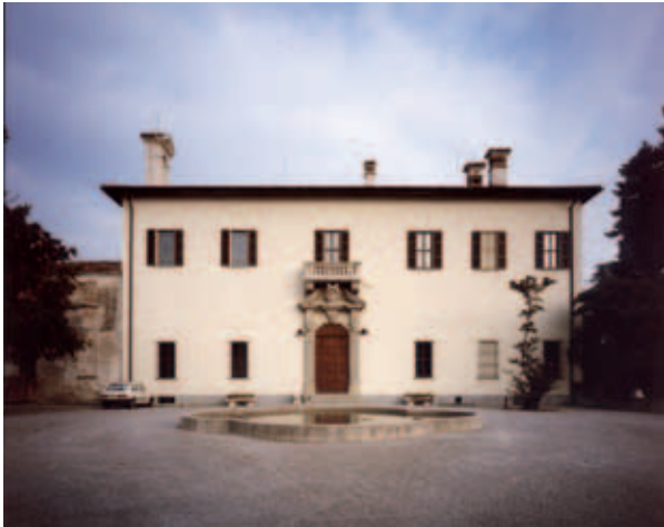
Restauro di Villa Imbonati - Cavallasca 1987
